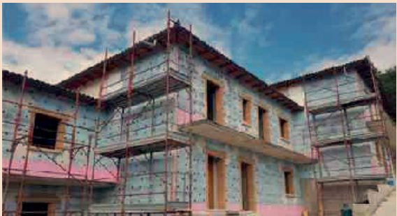
Isolamento a cappotto (complesso residenziale Roma)
